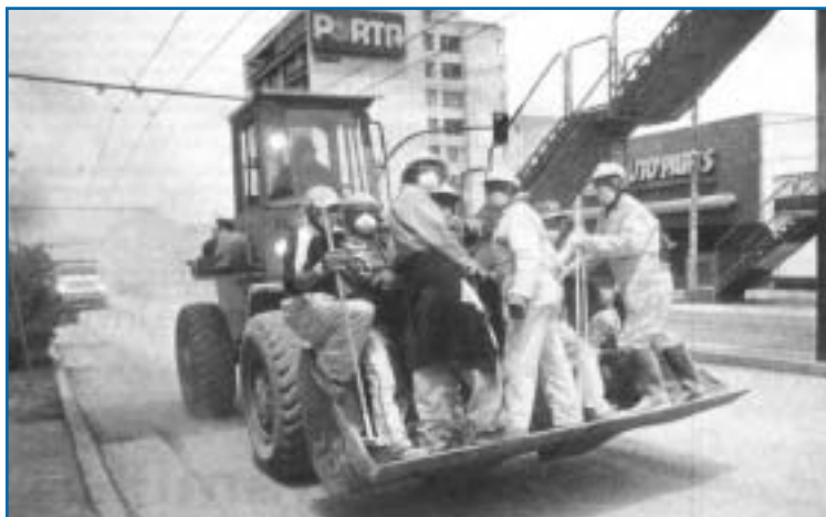
Personal municipal que realizó la limpieza de las vías y del carril del trolebús. Obsérvese el equipo de recolección constituido por una cargadora.
