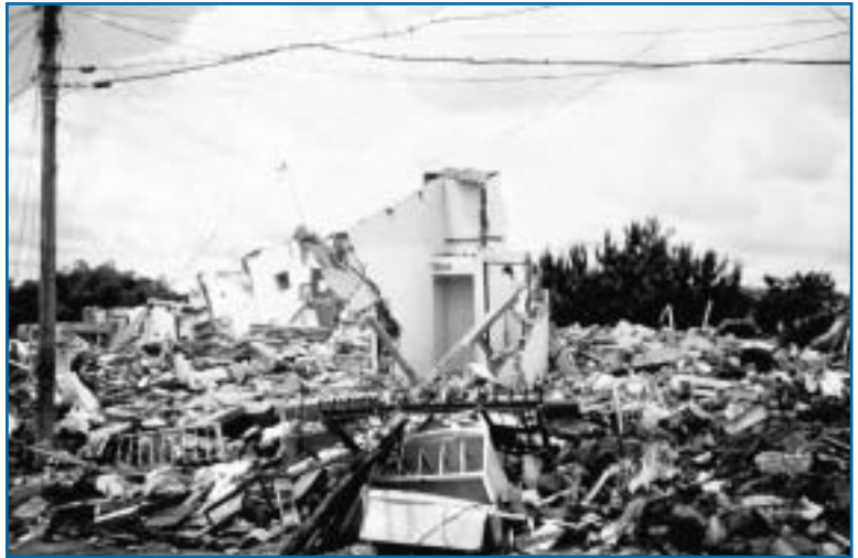
Generación de escombros después del terremoto de Armenia, Colombia.
