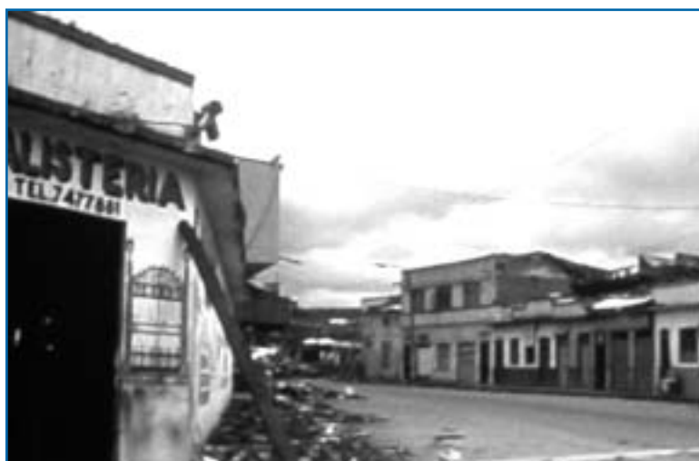
Daños generados por el sismo del 25 de enero de 1999 en Colombia.
