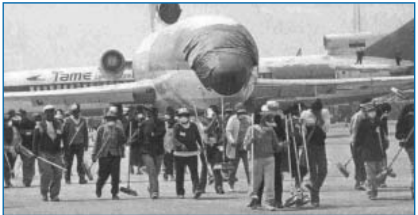
Se contrató 800 personas para la limpieza del aeropuerto. Después de que se levantó la capa de ceniza manualmente se realizó un barrido final con barredoras mecánicas.
