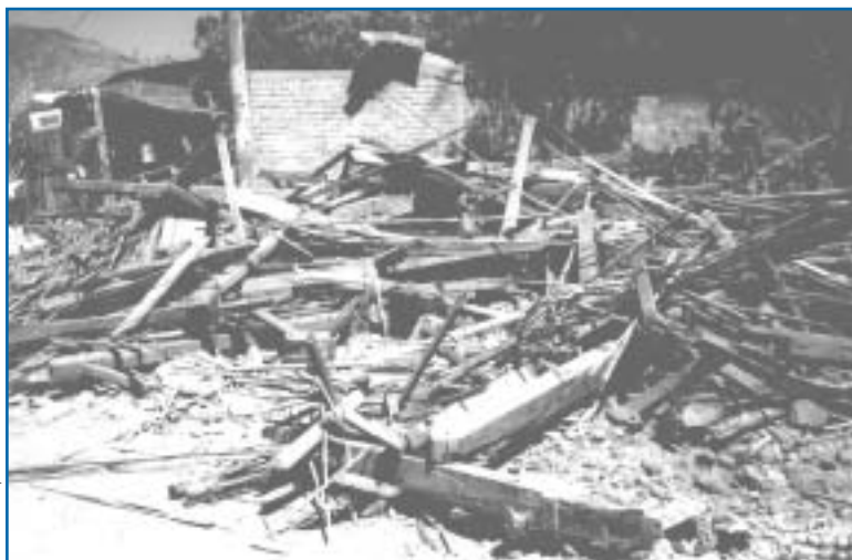
Bloqueo de vías por escombros.
